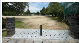
岩国市 南岩国町 第一街区公園 出入口部分
